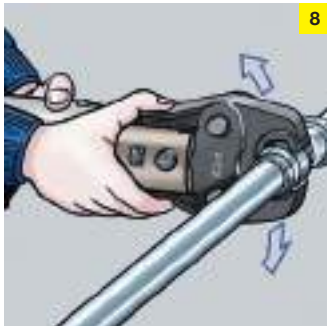
По окончании опрессовки раскройте пресс-клещи.
